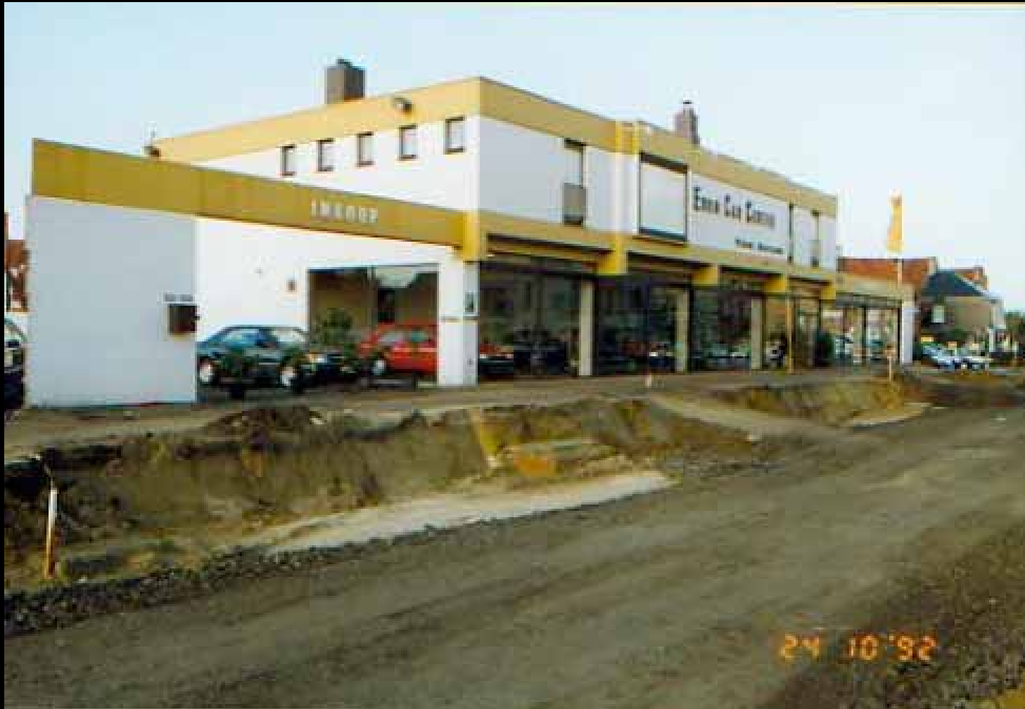
1992 Onteigening voorstrook en aanvang openbare werken aan de Brusselsesteenweg
